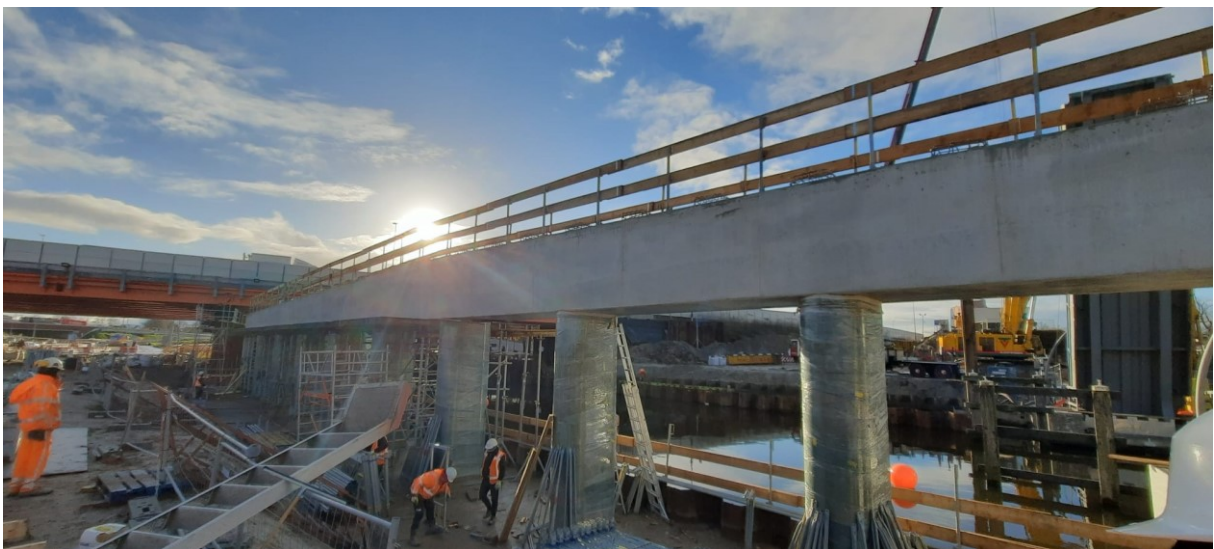
Tussensteunpunt nieuwe Julianabrug.
