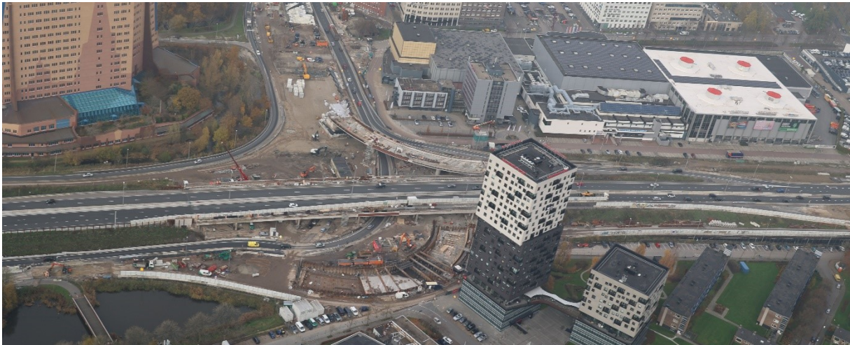
De duidelijk van elkaar gescheiden rijbanen om in het midden de werkzaamheden ten behoeve van een nieuw viaduct te verrichten bij het Vrijheidsplein.
