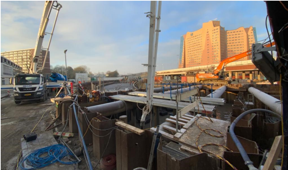
Onderwaterbetonstort Vrijheidsplein.
