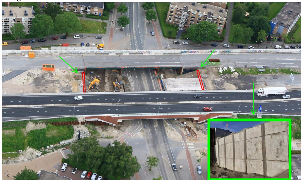
Locatie werkzaamheden en voorbeeld stalen balken met panelen.
