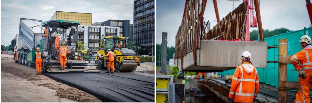
Aanleg tijdelijke wegen Vrijheidsplein en verbreden viaduct Laan Corpus den Hoorn (foto's: Aanpak Ring Zuid)
