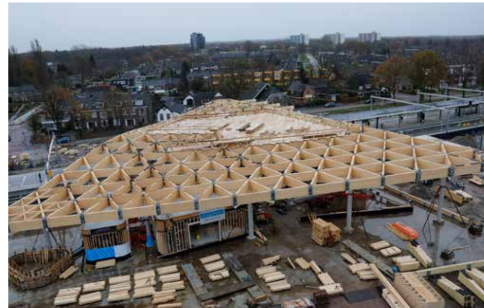
IN HET TREINVRJE WEEKEND IN NOVEMBER IS GEWERKT AAN DE LUIFEL OVER HET STATION. FOTO: GUIDO VAN DEN BERG.
