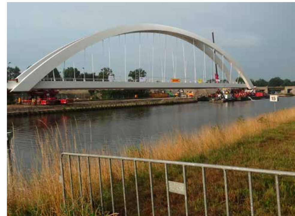
HET INVAREN VAN DE SPOORBRUG BIJ ZUIDHORN IN DE ZOMER. FOTO: PRORAIL.
