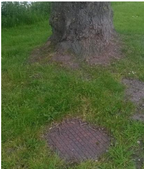
Foto met boom 67 en de bestaande inspectieput
