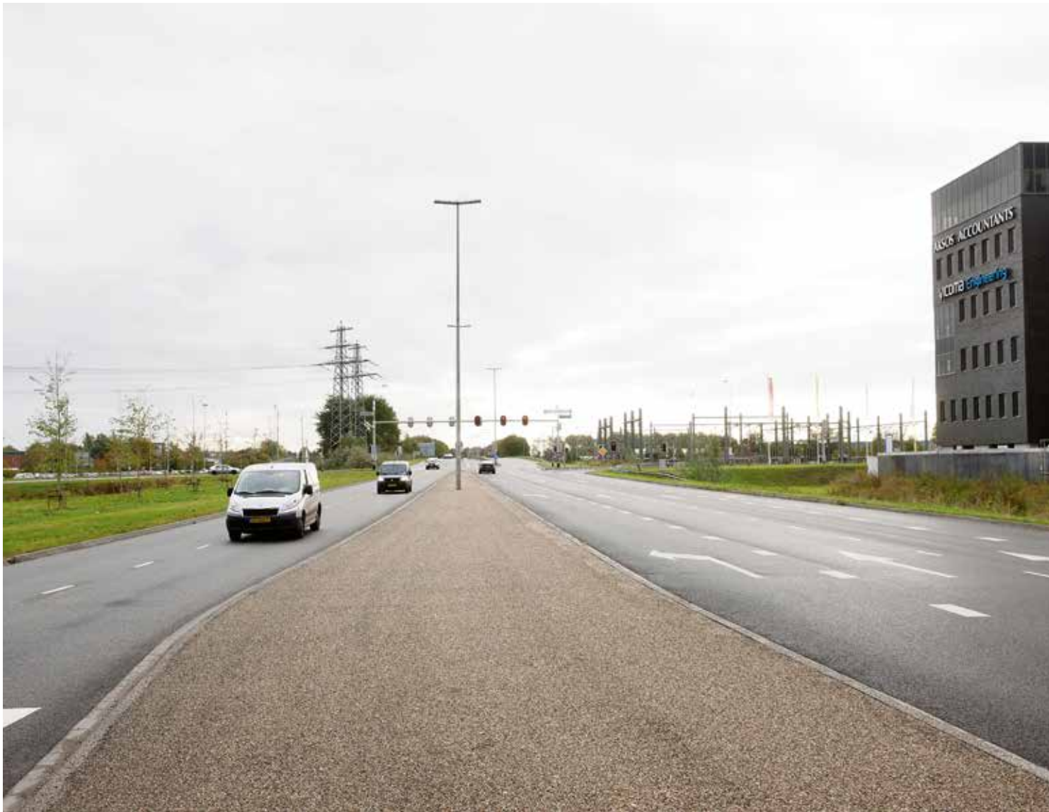
OP DE EUROPAPLEIN, DE OUDE A7, WORDT HET NA DE OMBOUW EEN STUK DRUKKER. HET VERKEER VANUIT DE RICHTING HOOGEZAND NAAR HET CENTRUM, EN OMGEKEERD, GAAT DAN VIA DEZE ROUTE. FOTO: JEROEN VAN KOOTEN.
