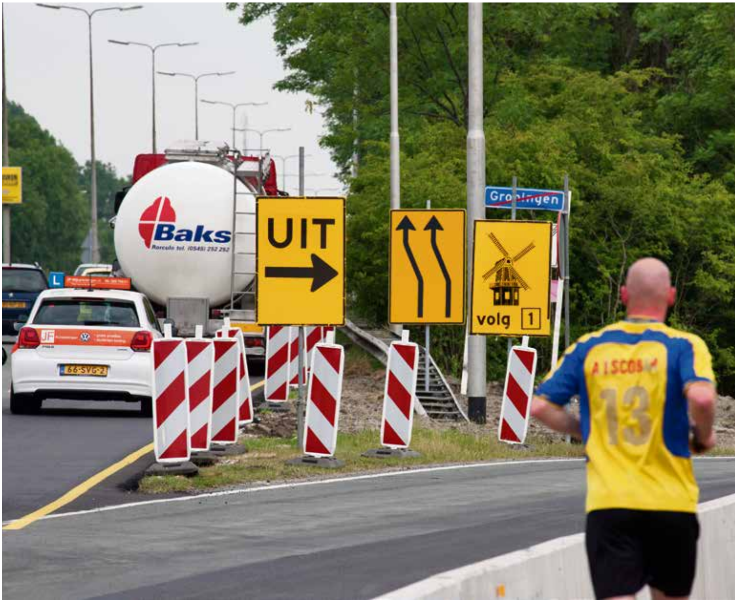
WERKZAAMHEDEN AAN DE NOORDLIJKE RING, IN DE ZOMER VAN 2013. BIJ DE WERKZAAMHEDEN AAN DE ZUIDELIJKE RINGWEG BLIJVEN STEEDS IN BEIDE RICHTINGEN TWEE RIJSTROKEN BESCHIKBAAR. FOTO: JEROEN VAN KOOTEN.
