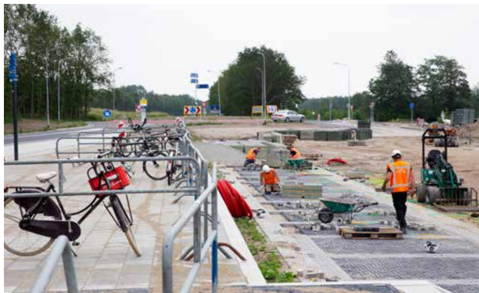
Bij de afrit Leek van de A7 is de P+R Leek in aanbouw. Foto: Jeroen van Kooten.
