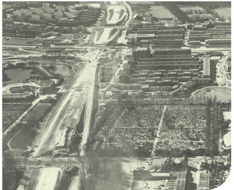
▲ Aanleg zuidelijke ringweg, eind jaren zestig. Rechts op de foto de Zuiderbegraafplaats.
