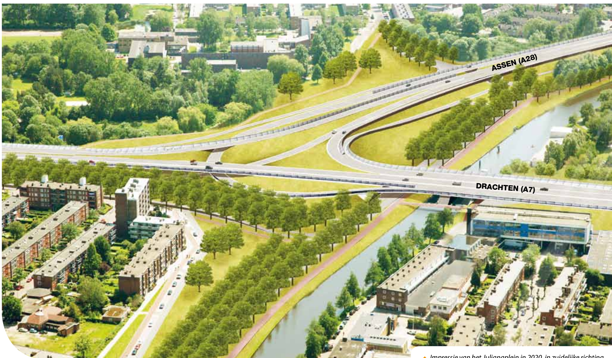
▲ Impressie van het Julianaplein in 2020, in zuidelijke richting.
