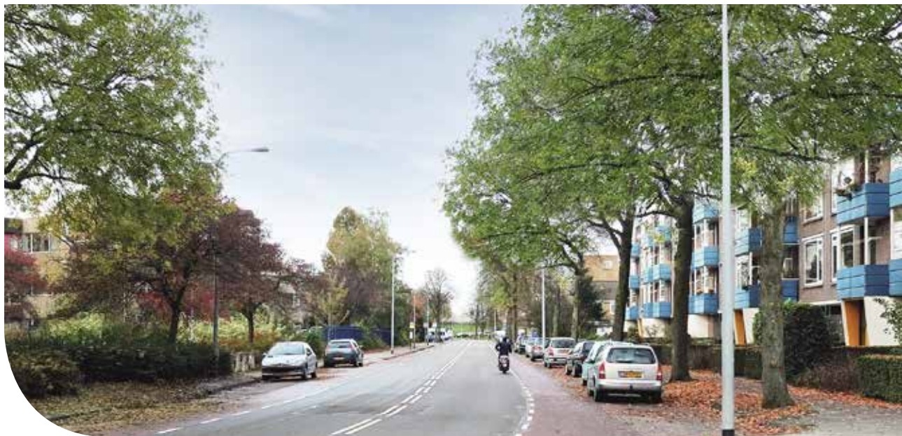
De Vondellaan in de huidige situatie.
